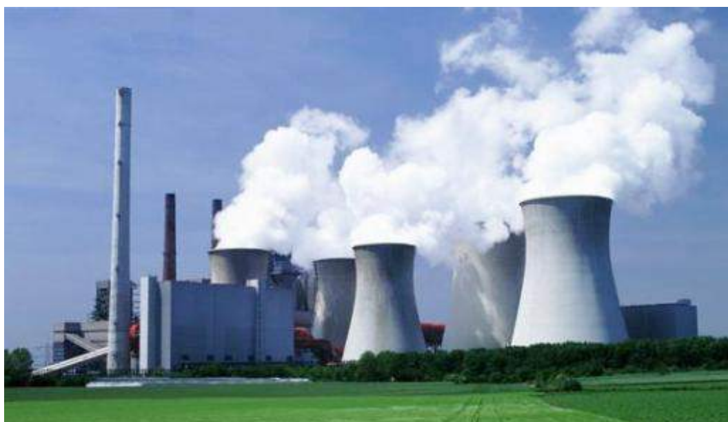
شکل ۱: نیروگاه حرارتی سیکل ترکیبی
